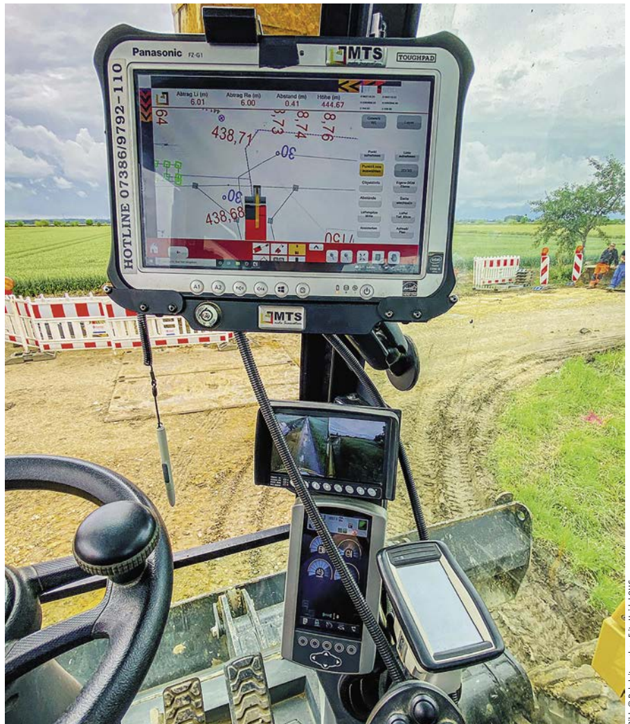
Das Tablet zeigt dem Baggerfahrer alle digitalen Daten an, die für die Baumaßnahme erforderlich sind. Dadurch entfällt das Handaufmaß.
