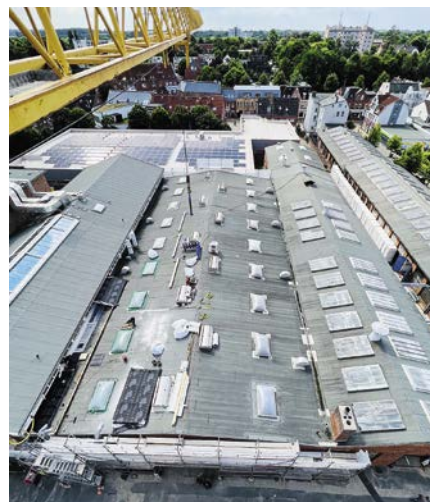
Blick vom Turmdrehkran auf die Dachsanierungsbaustelle zum Projektstart
