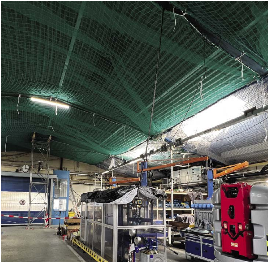
Personenauffangnetze inkl. Kleinteileschutznetz direkt unterhalb der Stahlkonstruktion mit Aufhängeseilen montiert
