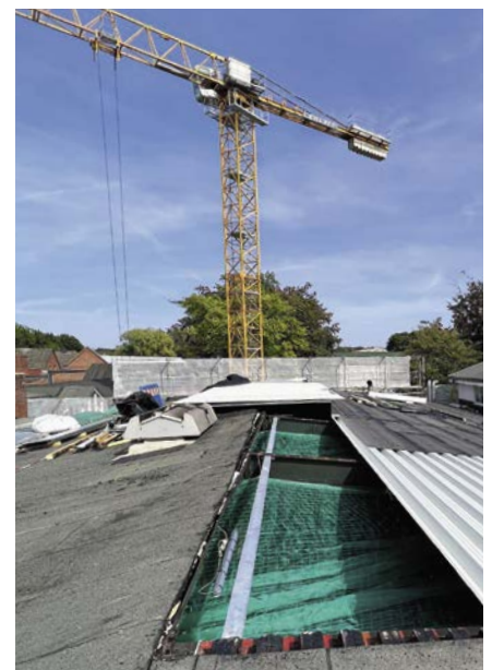
Die Schutznetze sind fast über die gesamte Länge des Daches gespannt.
