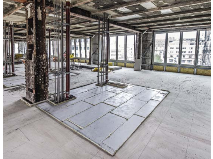
In den Bereichen der späteren Badezimmer wurden die Estrich-Elemente fermacell® Powerpanel TE eingesetzt, die speziell für Böden mit starker Feuchtebelastung konzipiert sind.
