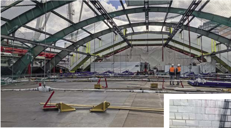
Abb. oben: Die erneuerten horizontalen Zugbänder im Vordergrund
