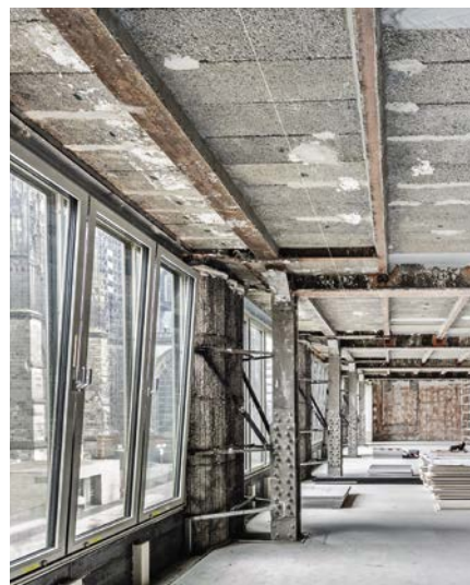
In den oberen Etagen des unter Denkmalschutz stehenden Blau-Gold-Hauses sollen ebenfalls Hotelzimmer und Suiten untergebracht werden. Gut zu sehen: die Stahl-Bims-Decken, die eine besondere Herausforderung für die Planer darstellten.
