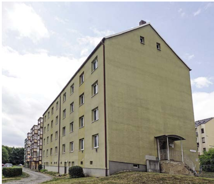
Greizer Gebäude vor der Sanierung
