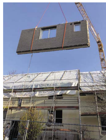
Montage eines Fassadenelements
