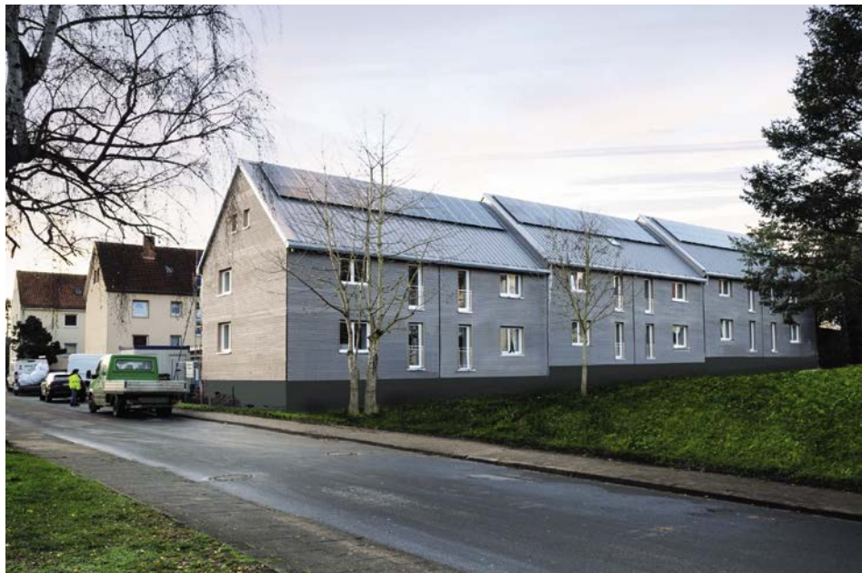
Abb. diese und nächste Seite oben: Gebäude in Hameln nach der seriellen Sanierung
