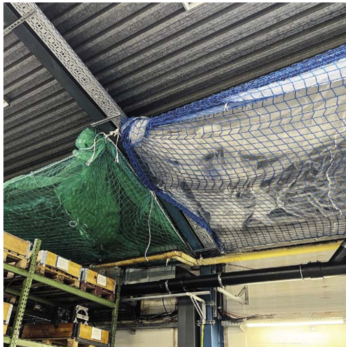
Personenauffangnetze inkl. Kleinteileschutznetz wurden direkt unterhalb der Stahlkonstruktion mit Aufhängeseilen montiert.
